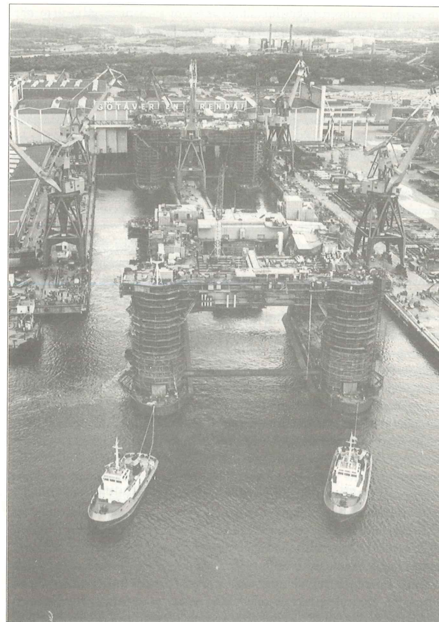
Byggande av offshoreplattformar vid Götaverken Arendal. Notera hur plattformarna byggdes med ett benpar i varje docka. (Foto: Varvshistoriska Föreningen.)
